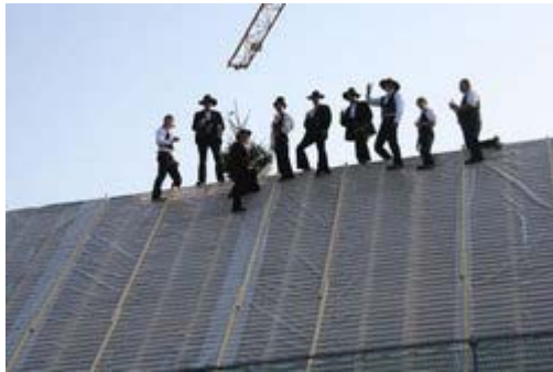
Scheune nimmt wieder Gestalt an
